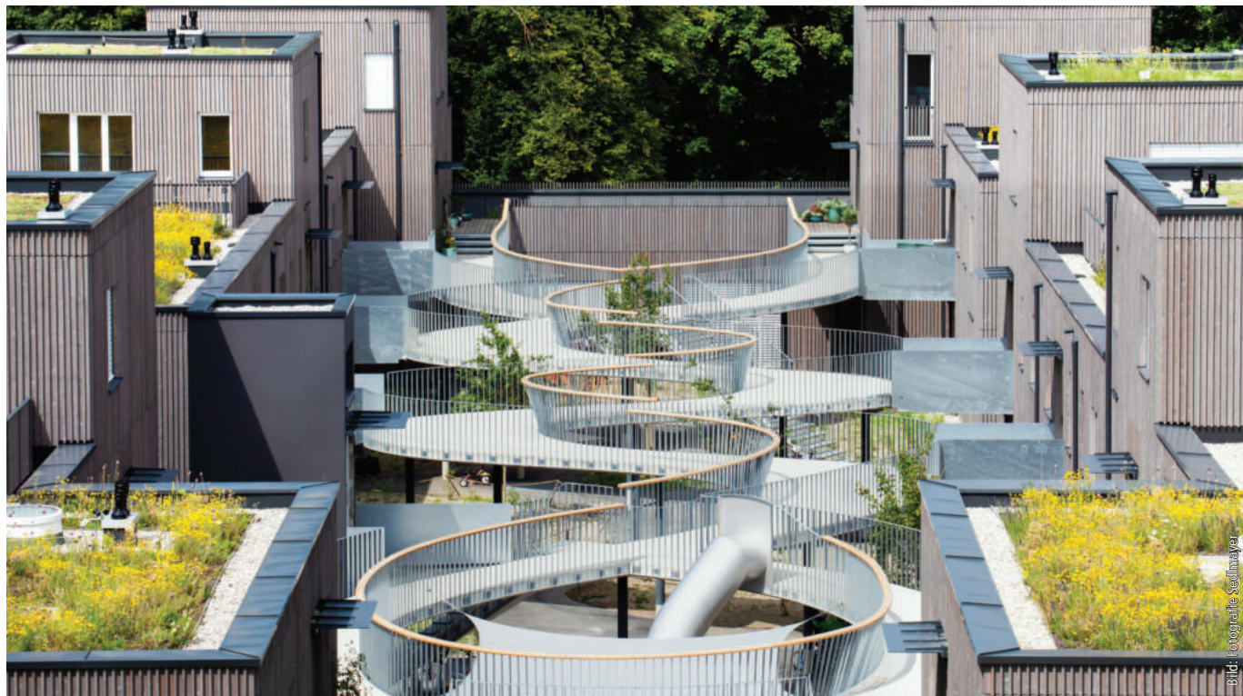
Der mäandrierende Laubengang dockt punktgenau an den einzelnen Wohneinheiten des Obergeschosses an. Anders als konventionelle Laubengänge, die uneingeschränkte Blicke in die Wohnzimmer der Nachbarn ermöglichen, schützt der Mäander die Privatsphäre und führt zu geringeren Verschattungen der unteren Wohnbereiche.
