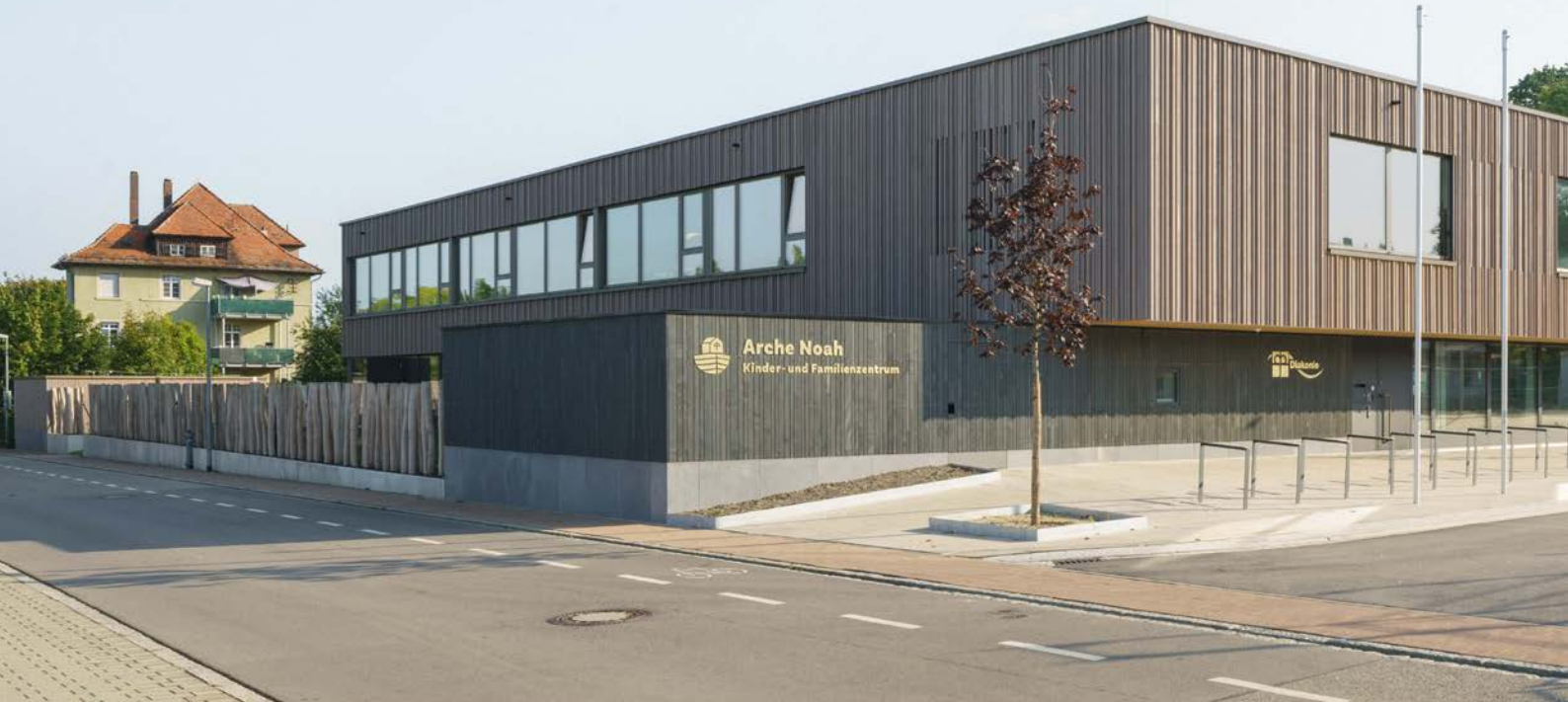
Das Kinderhaus „Arche Noah“ in Weißenburg bietet 160 Kindern in Kinderkrippe, Kindergarten und Hort Platz. Das zweigeschossige Gebäude wurde in einer Holzmischbauweise aus Holzrahmenbau und Holzmassivbau geplant und errichtet.
