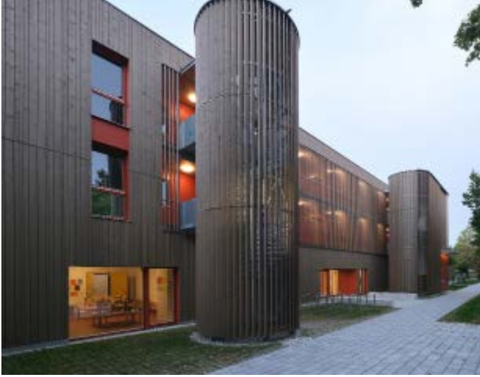
▲ Bei der Kinderkrippe wurden außen tragende Holztafelwände eingesetzt
